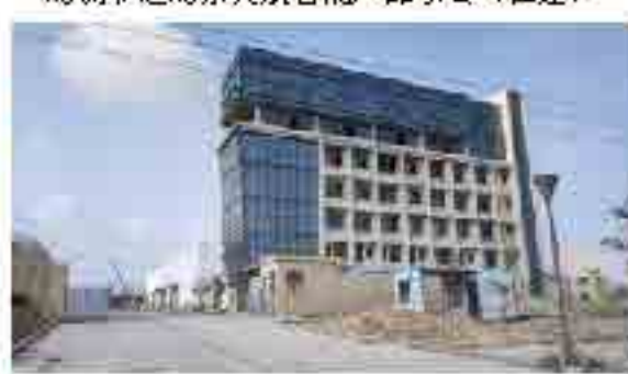
南侧湛江锦程仓储配送有限公司
