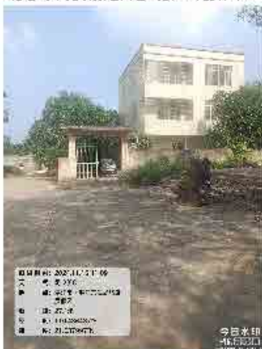
德老村未完成搬迁的居民楼（零星分布）
