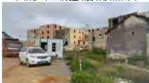
东侧东简圩村（拆除旧房）
