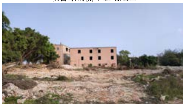
项目东侧德老村 2（拆除旧房 2）
