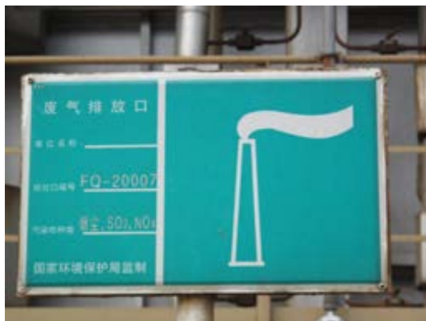
图 8.1-1 废气排放口规范化标志牌（样牌）
