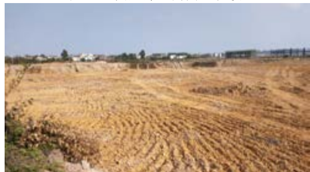
厂址地块北部（东南向）现状
