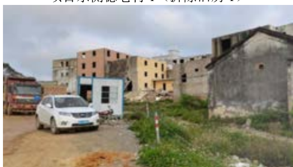
项目东侧东简圩村（拆除旧房）
