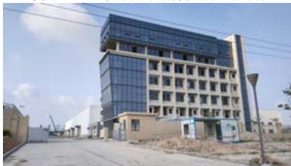
南侧湛江锦程仓储配送有限公司
