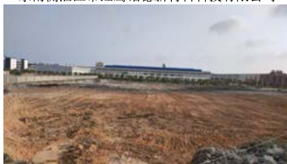
项目东南侧平整场地区
