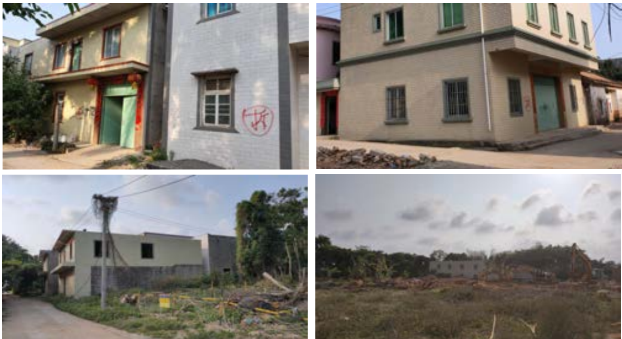
图 2.3-1 项目东侧德老村、东简圩村旧房屋拆除现状
