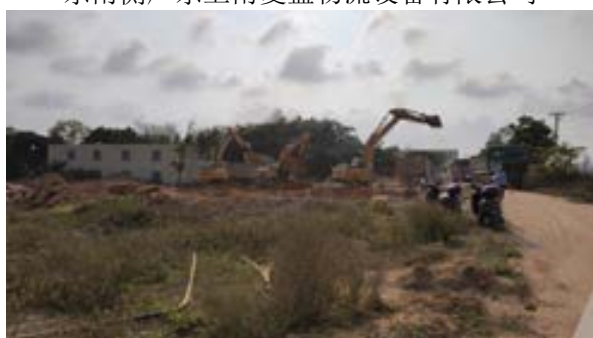
项目东侧德老村 1（拆除旧房 1）
